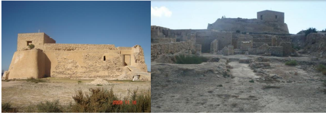
FIG.5 : BORJ EL H'SAR ; SOURCE : CLICHÉ AUTEUR
